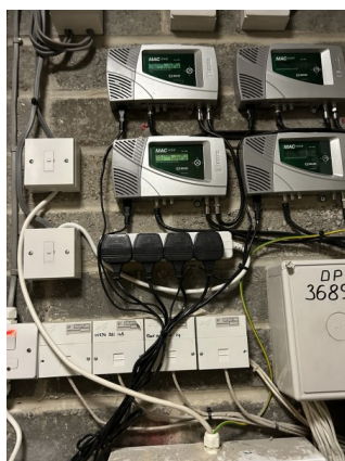
AV equipment requiring PAT testing.
